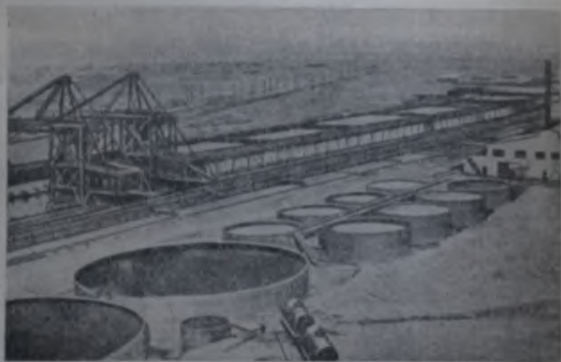
Рис. 106 Вид предприятий по переработке селитры в Чили; на первом плане хранилище с раствором селитры, на заднем — приспособление для разгрузки (мостовой кран).
