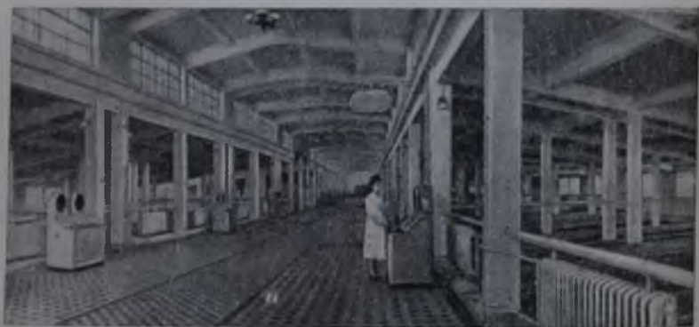
Рис. 49. Фильтры Рублёвской водоочистительной станции (Москва).
